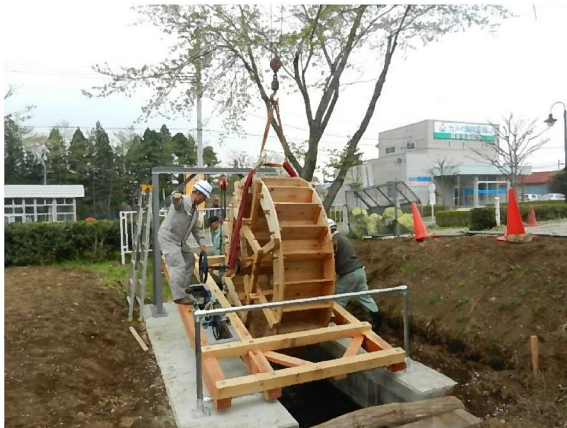
写真.3 水車据え付け
