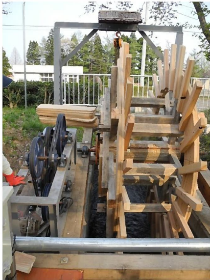
写真.7 羽根部分のみを新材で更新
