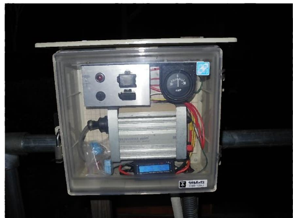
写真.12 インバーターで 100V に変換
