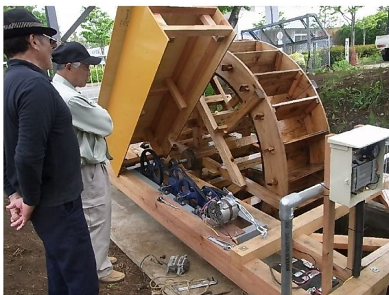
写真.5 初代の増速・発電装置(出力不足)
