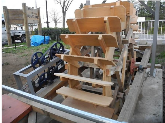
写真.8 補修が終了した水車(下掛け式に変更)
